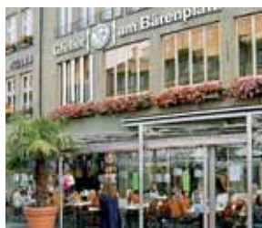
Gfeller, Bern: Sanierungsmassnahmen eingeleitet
